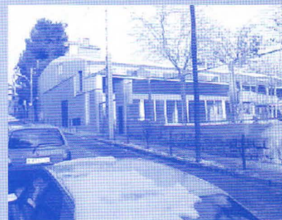
Entrada de l'Escola, actualment.
